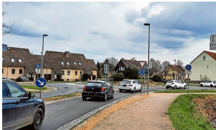
In Treuenbrietzen stehen die Sanierung und der Umbau des Kreisverkehrs in der Jüterboger Straße an. Bis August geht es dann nur einspurig voran.
